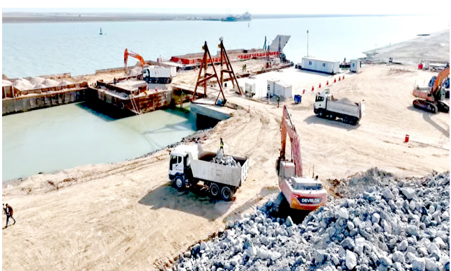
تنفيذ: انطلاق المرحلة الثانية لتنفيذ طبقة الصخور الواقية للنفق المغمور
