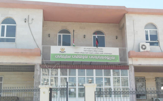
مكتبة: مبنى مكتبة أوقاف السليمانية
