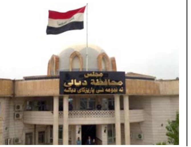
جانب من بناية مبنى محافظة ديالى
