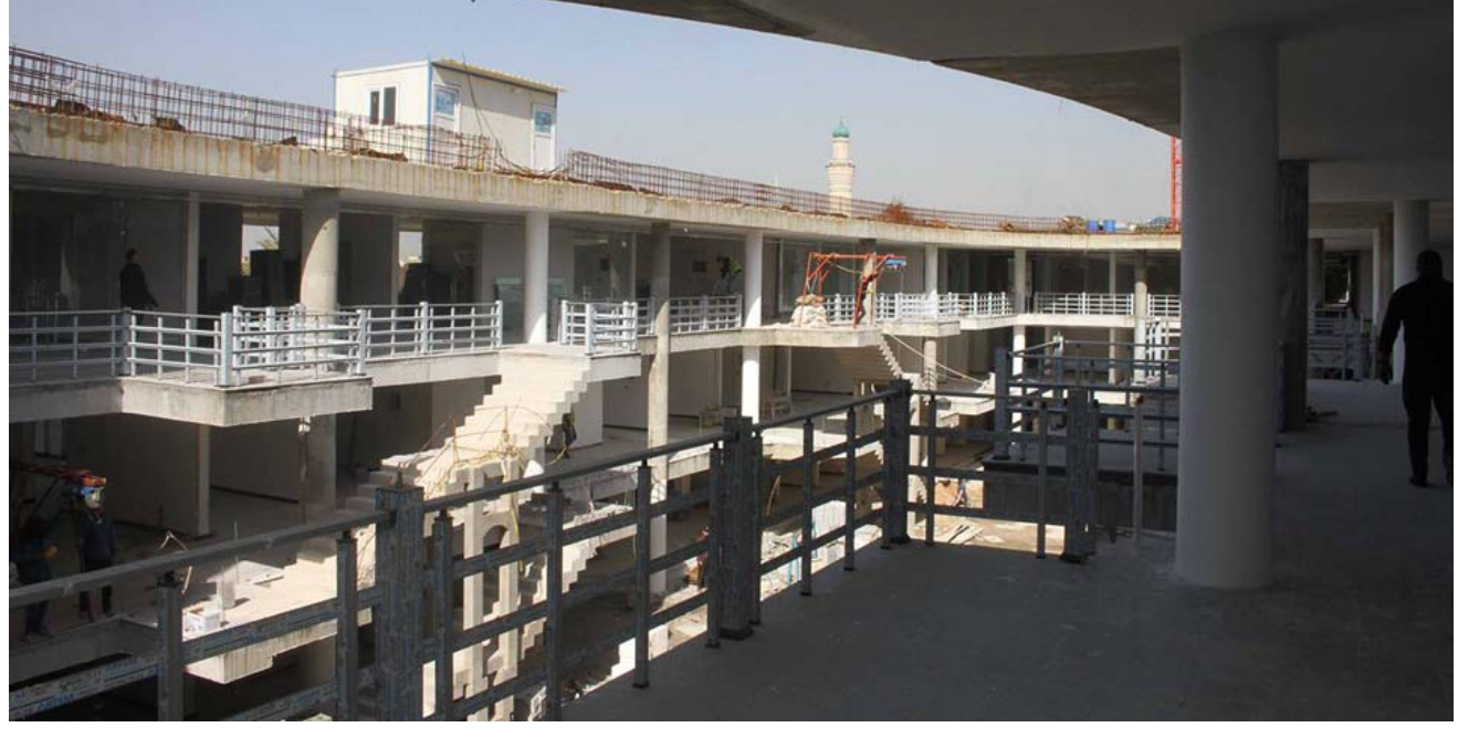
مجمع: جانب من مجمع سكني قيد الإنشاء في بغداد
