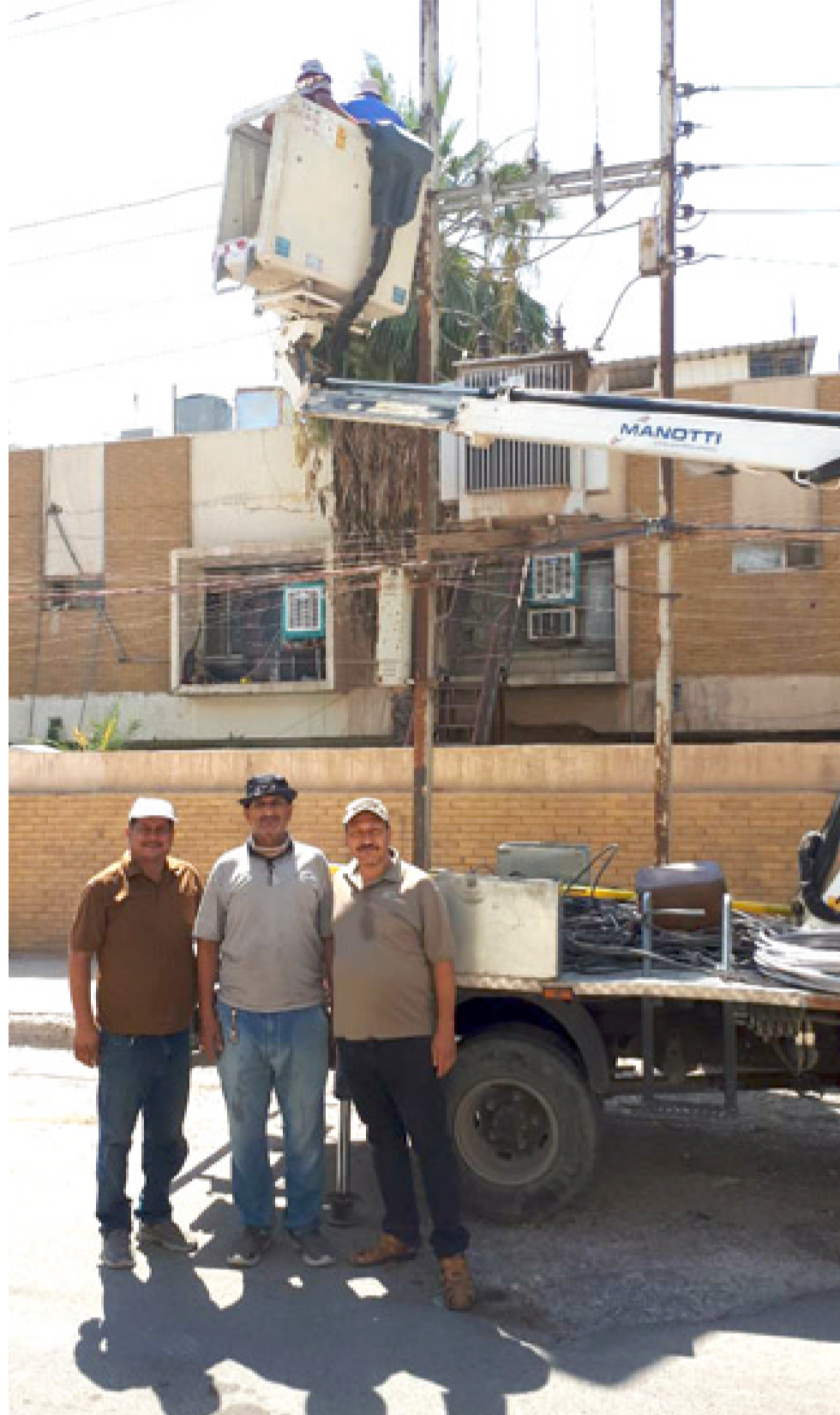
إصلاح: عمال الصيانة يجرون إصلاح عطل في الكهرباء بمنطقة البتاوين ببغداد
