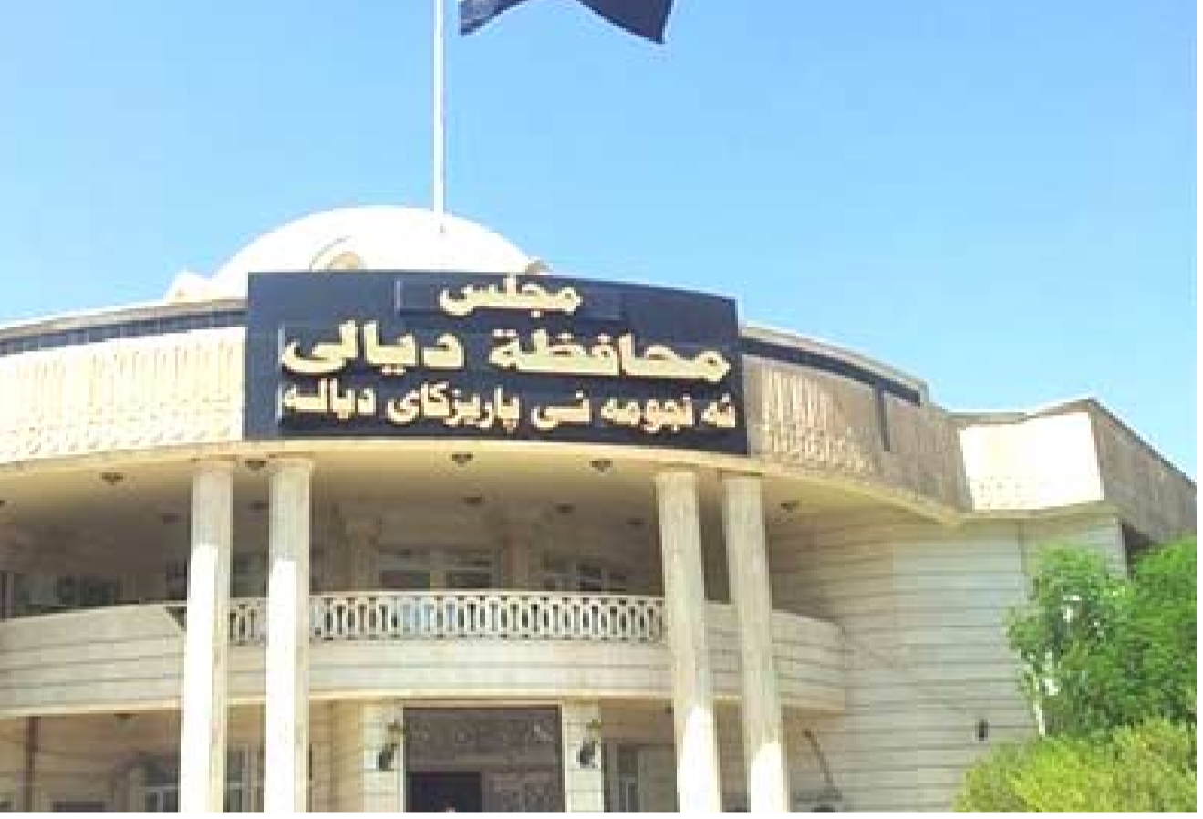
مبنى، جانب من مبنى محافظة ديالي
