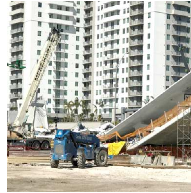
طريق رافعة قرب جسر المشاة الذي انهيار فوق طريق سريع في ميامي بولاية فلوريدا
