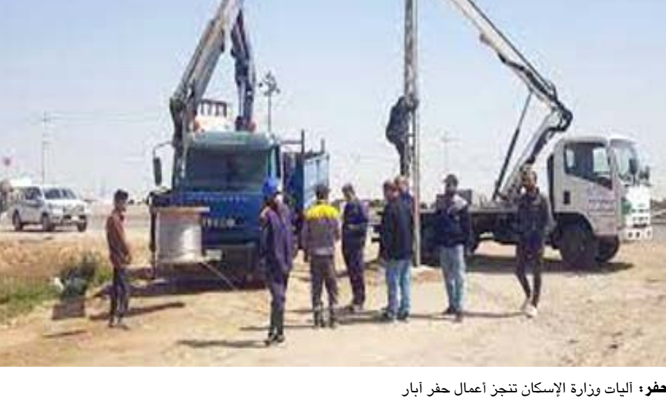
حفر: أليات وزارة الإسكان تنجز أعمال حفر أبار
