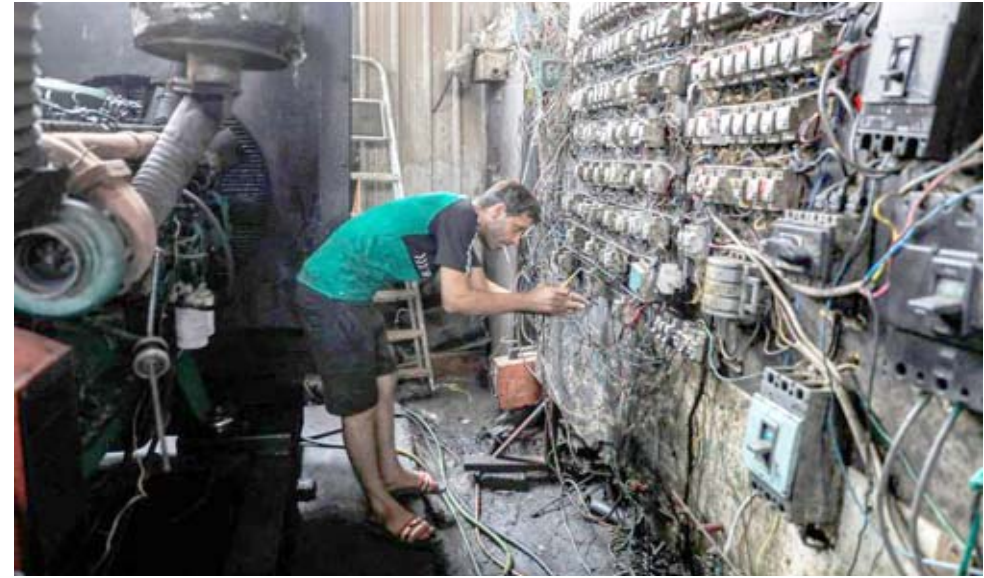
مولدة: مشغل إحدى المولدات الاملية يقوم بصيانة الربط الكهربائي
