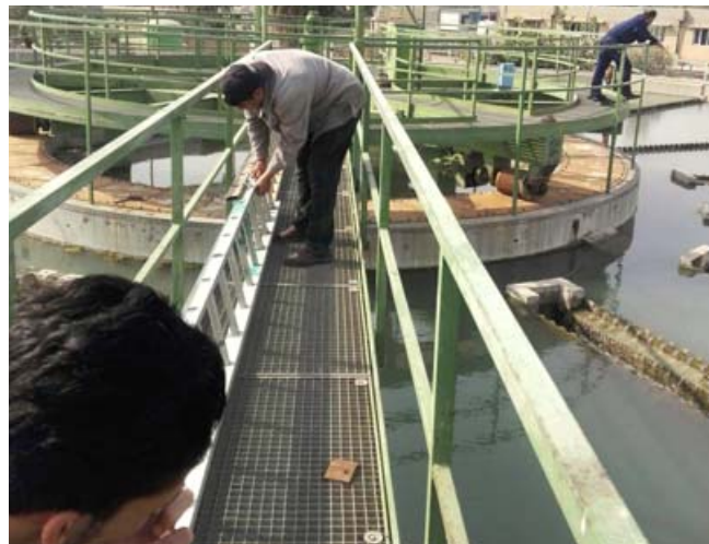
معالجة: عمال أمانة بغداد يقومون بمعالجة ومتابعة مضخات المياه في مشروع الدورة
