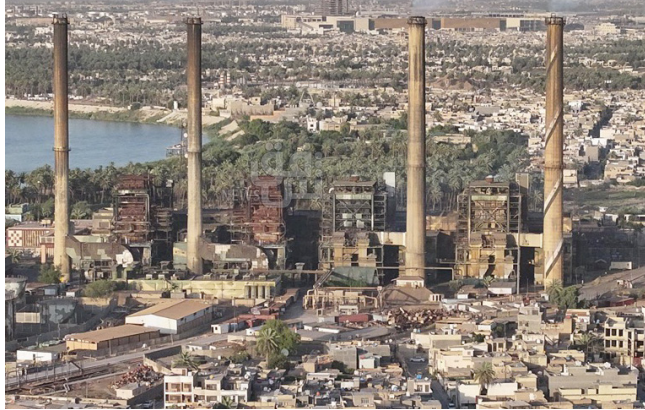
هي: محطة كهرباء، وسط حي سكني
