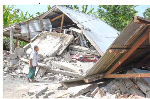
دمار: اثار الدمار الذي لحق بالمباني في هايتي اثر زلزال اوقع مئات القتلى والجرحى
