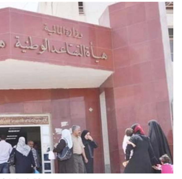
مبنى هيئة التقاعد الوطنية
