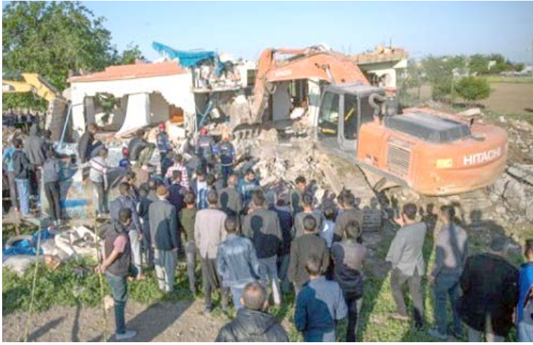
انقراض: أليات ترفع انقاض البيوت المتهدمة نتيجة الزلزال في اديمان التركية
