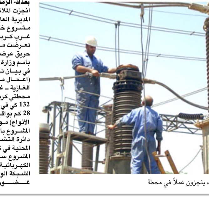
عمال الكهرباء ينجزون عملاً في محطة
