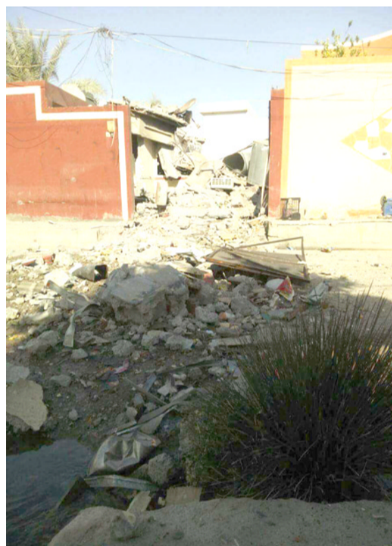
تضرر: منازل مدمرة جراء عمليات قصف من أطرف مجهولة في قضاء طوز خورماتو
