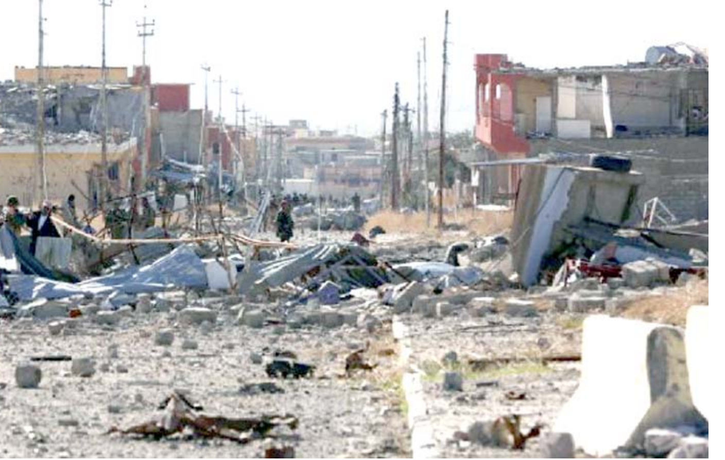
اضرار : صورة ارشيفية للاضرار التي اصيبت بها البنى التحتية في مدينة الرمادي جراء عمليات التحرير من داعش
