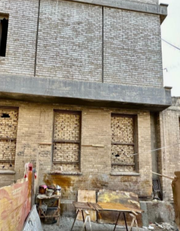
الواجهة الشمالية للبناية
